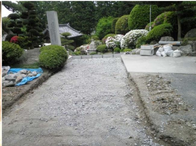
本堂正面の階段上部の沈下。石柱が前方に傾く。
