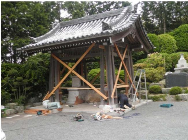
お水屋の柱が土台となる束石からズレ込む！(あぶなく倒壊寸前の状態！) 4月11日
